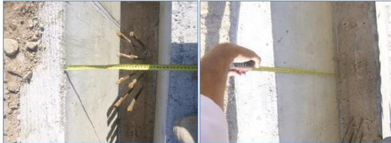
Foto 5. Rilievo dimensionale dell'innesto 40x100 cm a bicchiere della trave di fondazione sul filo "A" (29/08/2018)
