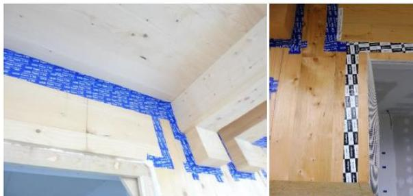
Foto 46. Applicazione tape per la tenuta all'aria e all'acqua sul lato esterno (16.04.2019 a sx, 30.05.2019 a dx)
