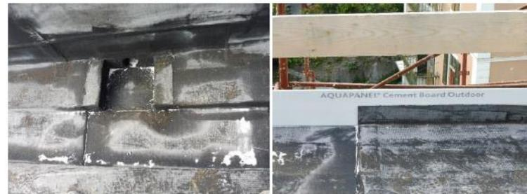
Foto 38. Controlli sull'esecuzione delle impermeabilizzazioni del 1° strato in prossimità degli scarichi e dei pannelli Aquapanel di rivestimento della testata del solaio del terrazzo del quarto piano (30.05.2019)
