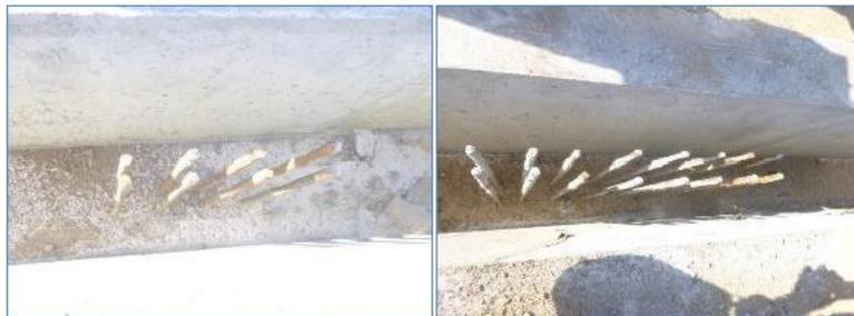
Foto 7. Ferri di "ripresa" per l'inserimento delle pareti in c.a. prefabbricato sulla trave di fondazione sul filo "A" (29/08/2018)
